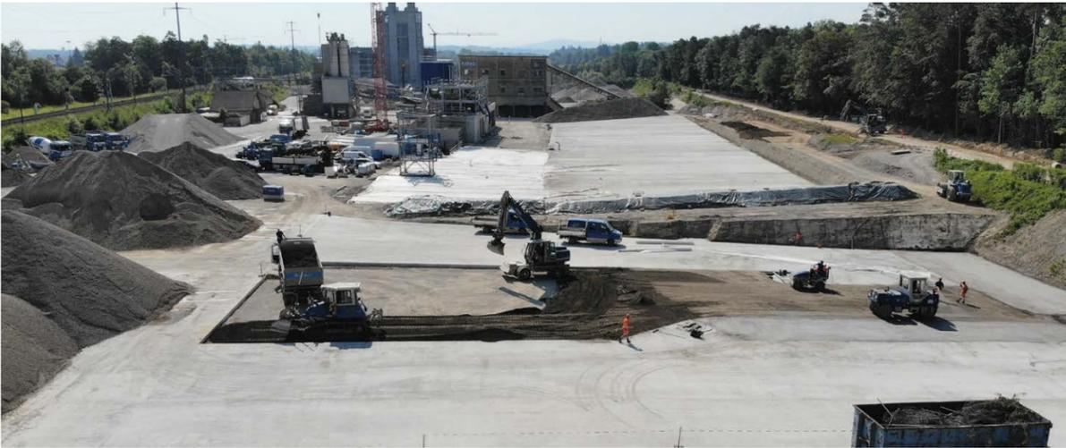
Das rund neun Hektar grosse Areal der KIBAG Kies Weinfelden AG wird umfassend neugestaltet. Im Rahmen dieses Grossprojekts ist die NRP Ingenieure AG mit der Projektierung der Platzflächen – teilweise in Walzbeton, der Zufahrtsstrassen, Entwässerungsanlagen sowie der Werkleitungen beauftragt. Besonders herausfordernd
