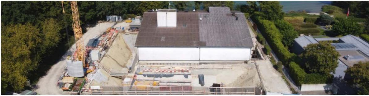
Die Leistung des Seewasserwerks Kesswil ist als Folge eines zu geringen Querschnittes der Fassungseitung (DN 400 mm) stark vom jeweiligen Seewasserspiegel abhängig. Eine reduzierte Förderkapazität infolge niedrigem Seewasserspiegel führte bereits mehrfach zu Liefer einschränkungen und verunmöglichte die Deckung des Spitzenverbrauchs. Als Folge der Klimaveränderung und des erwarteten Bevölkerungswachstums sowie der Zunahme von invasiven Arten, wie der Quaggamuschel
